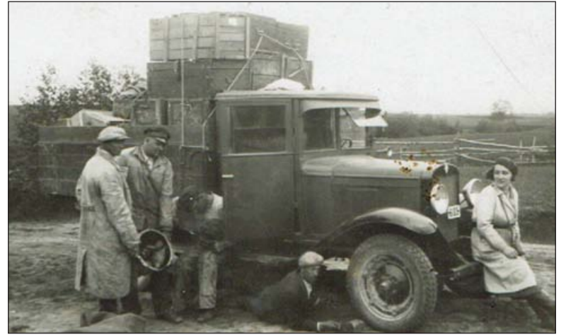
Autojuht ja transamehed teepeal kaubaveo autol käigukasti remontimas.
